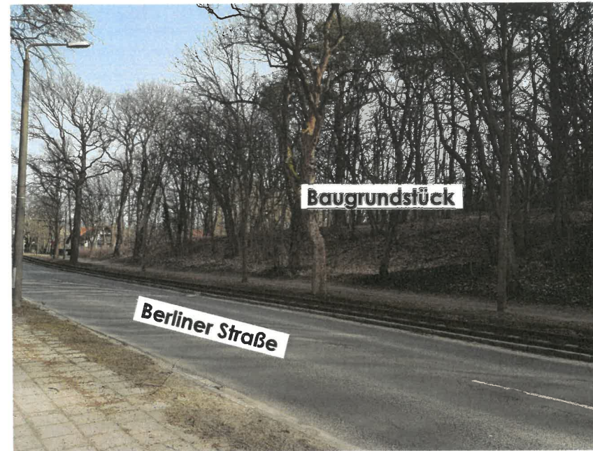
Foto 2: Blick in Richtung Nordosten entlang der Berliner Straße
