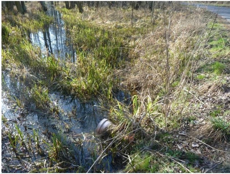
Abb. 8: Der Jordangraben mit dem unterdimensionierten Rohrdurchlass
